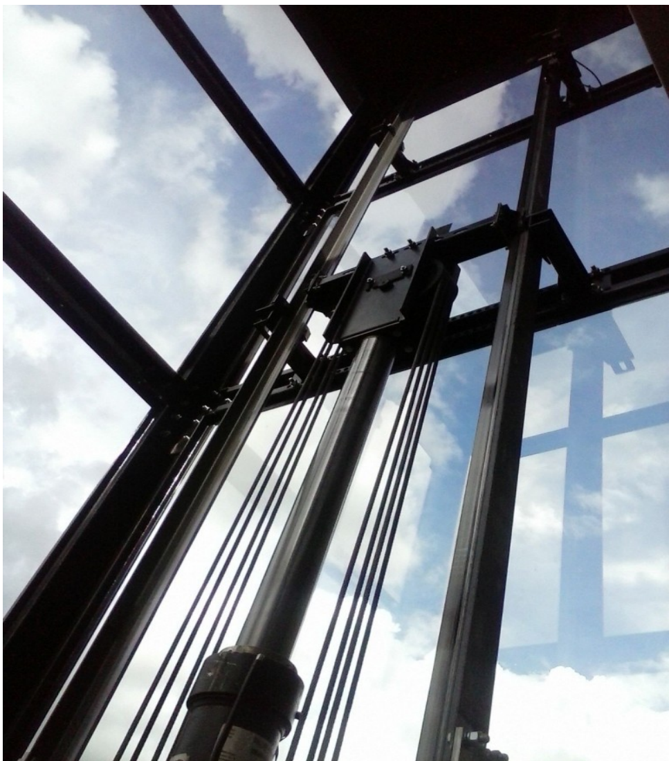
SISTEMA DE MOVIMENTAÇÃO HIDRÁULICO INDIRETO 2:1
